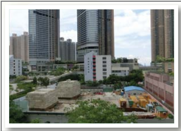
Tseung Kwan O Joint Student Hostel under construction (capital project) 興建中的將軍澳聯合學生宿舍 (基本工程項目)
