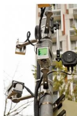
▲圖為位於香港中文大學的智慧燈柱。它是在BATS的基礎上，開發最先進的智慧燈柱無線通信技術。
